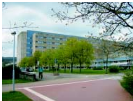
Kärnslukhuset i Skövde
